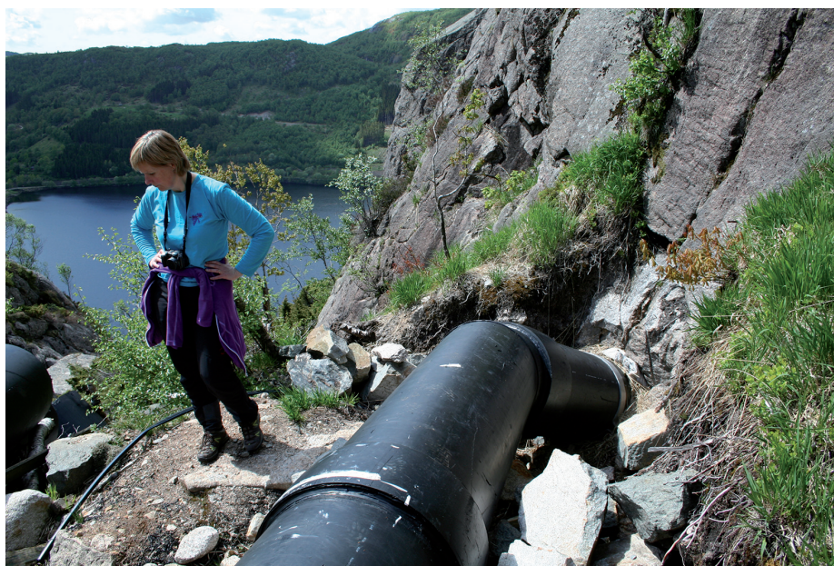
Figur 3. Eksempel på vannvei sprengt i fjell i et kraftprosjekt med effekt på 0,85 MW og produksjon 2,9 GWh. Foto: L. Erikstad.
