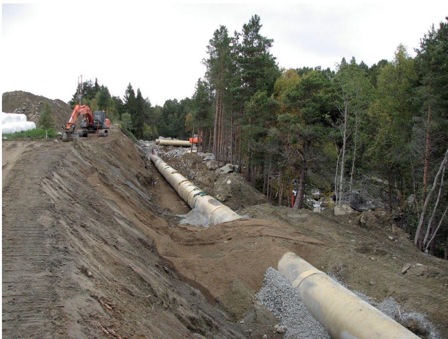
Figur 2. Nedgraving av rørgate til et småkraftverk med effekt på 3 MW og produksjon 8,10 GWh. Det er ikke uvanlig å båndlegge store arealer i forbindelse med anleggsfasen i småkraftprosjekter. Foto: D. Hagen.
