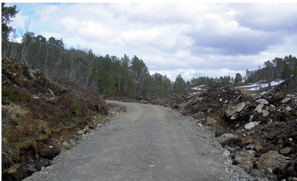
Figur 4. Eksempel på en eksisterende traktorvei som er opprustet Landbruksvei klasse 3 ved etablering av et småkraftverk med effekt 1,35 MW og produksjon 5,77 GWh. Foto: D. Hagen.
