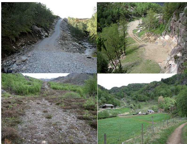
Figur 6. Spørsmålet om vei løses på svært ulike måter i kraftprosjektene, fra store veianlegg ned til forsterka kjørespor og noen anlegg som bygges helt uten vei. Omfanget av naturinngrep er avhengig av dimensjon og teknisk løsning, men også av naturtyper og terreng. Bildene viser en gradient fra omfattende til svært begrensa nye inngrep i småkraftprosjekt: ny vei med fylling i bekk (oppe til venstre), vei med fylling opp til boret tunell (oppe til høyre), utnytting av gammelt kjørespor (ned til venstre) og bruk av eksisterende gårdsvei (nede til høyre).
